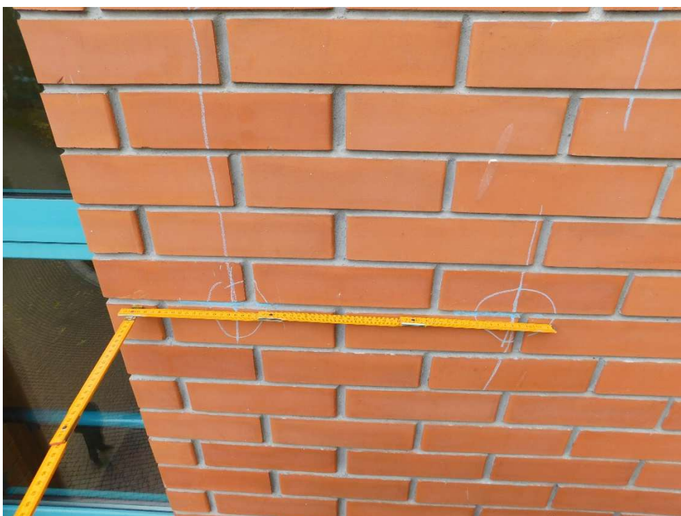
Fot nr 40. Pomiar rozstawu łączników na poziomie 2 piętra klatka 10
