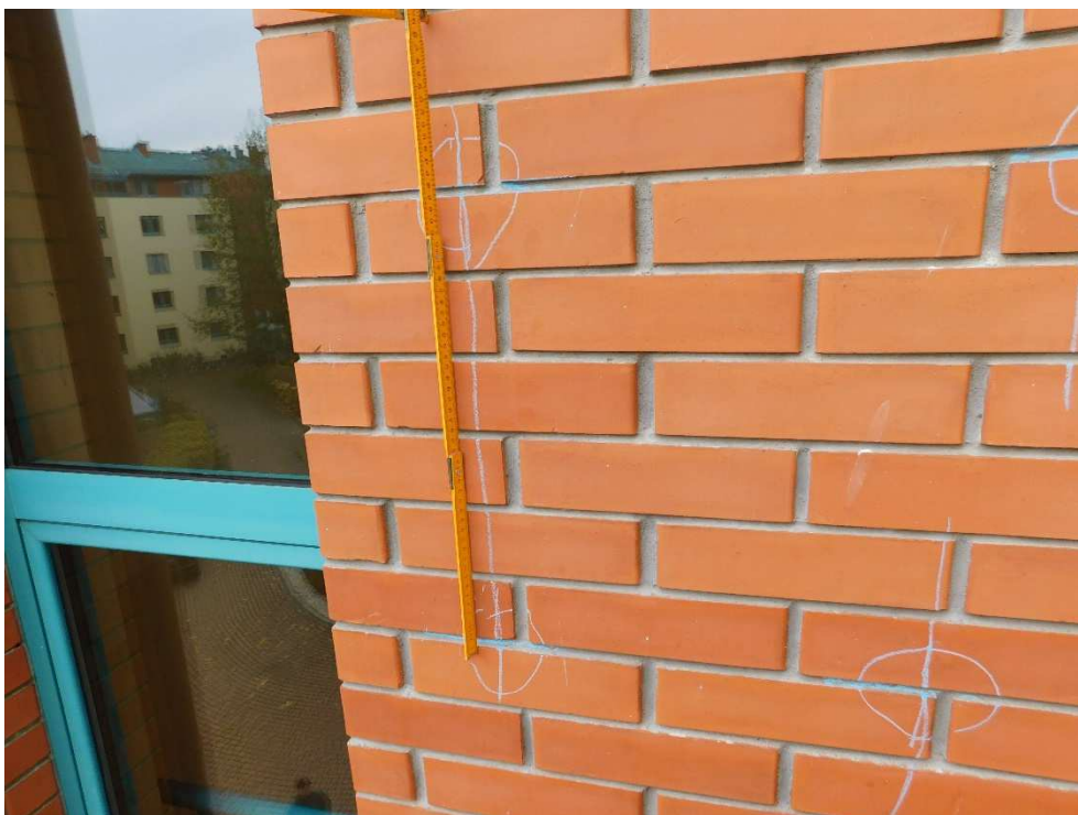
Fot nr 41. Pomiar rozstawu łączników na poziomie 2 piętra klatka 10
