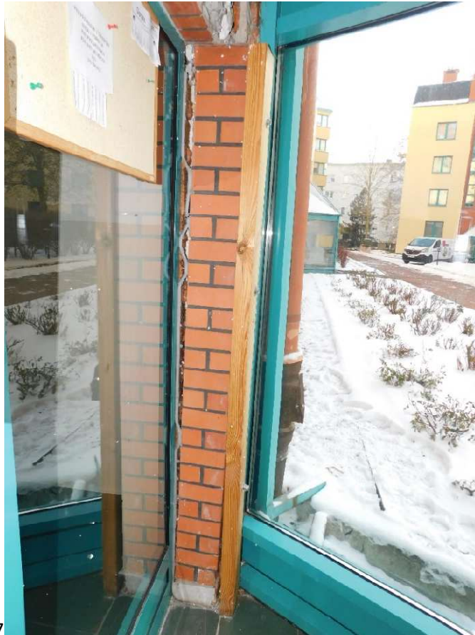
Fot nr 80. Odchylenie od pionu filarka murowanego w wejściu do klatki schodowej nr 7
