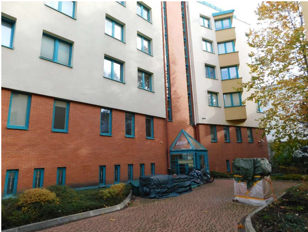
Fot nr 17. Widok ogólny elewacji
