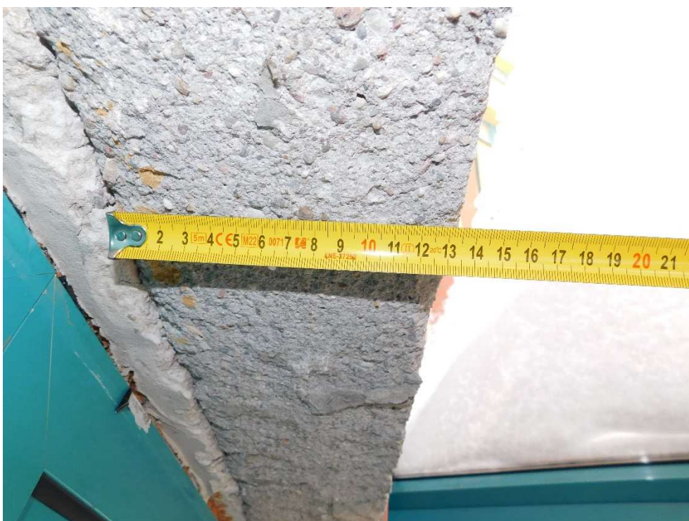
Fot nr 109. Widok nadproża wiatrołapu przy klatce schodowej nr 4
