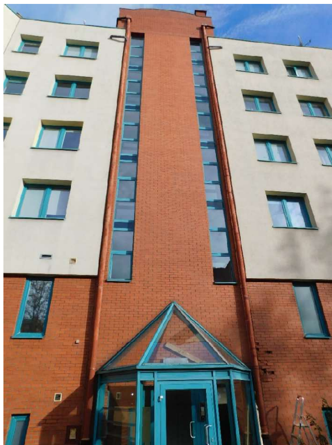
Fot nr 9. Widok ogólny elewacji
