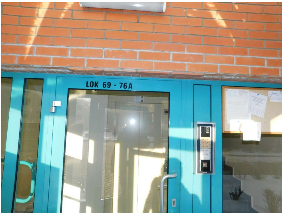
Fot nr 93. Widok wiatrołapu przy klatce schodowej nr 9
