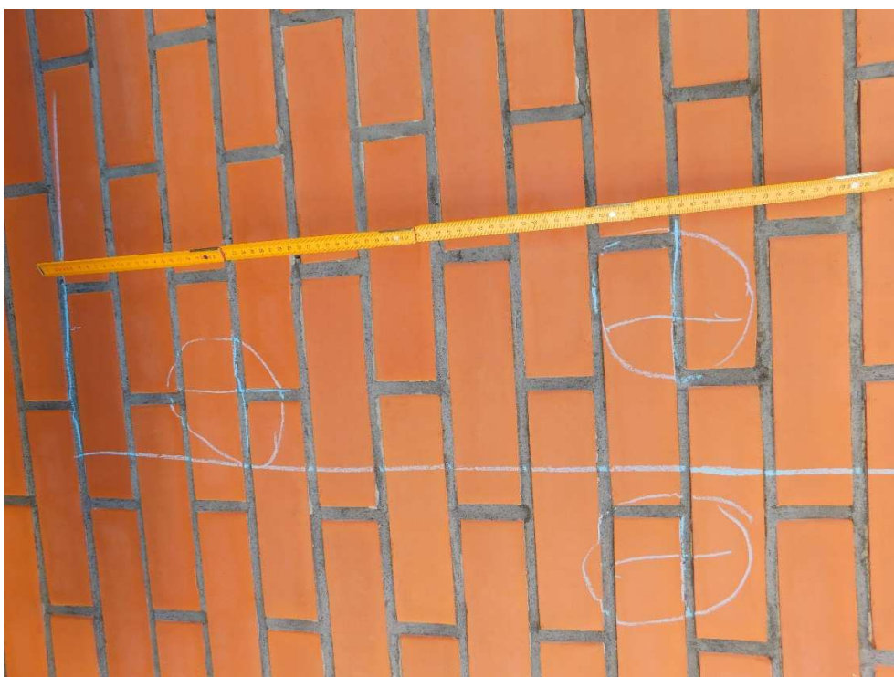
Fot nr 68. Pomiar rozstawu łączników na poziomie 3 piętra klatka 1
