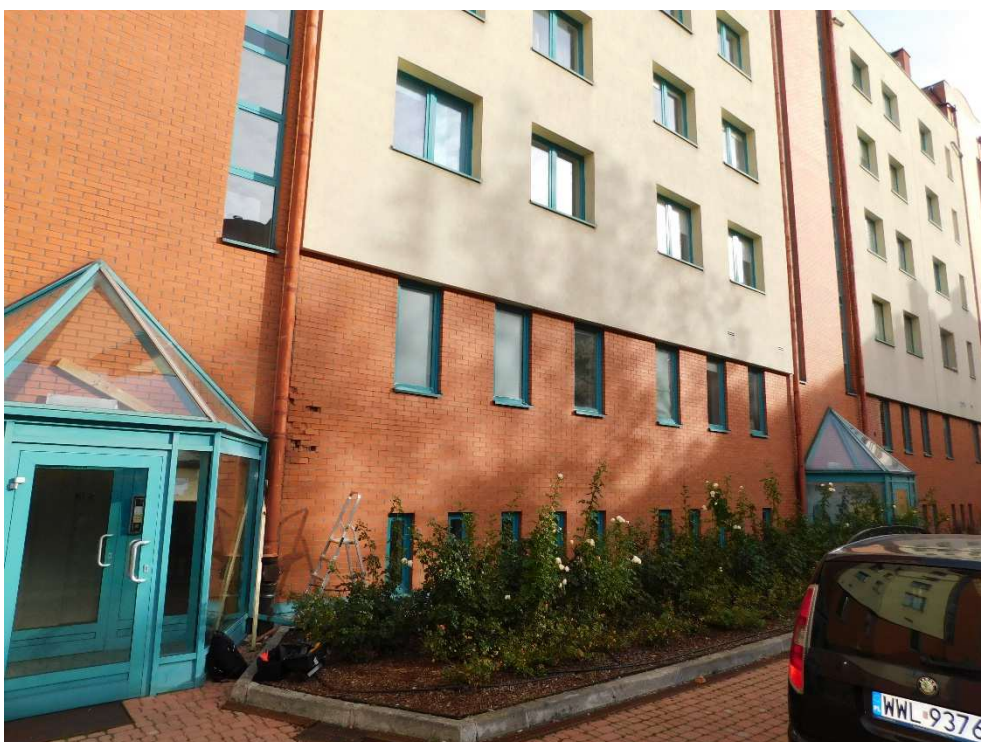
Fot nr 10. Widok ogólny elewacji
