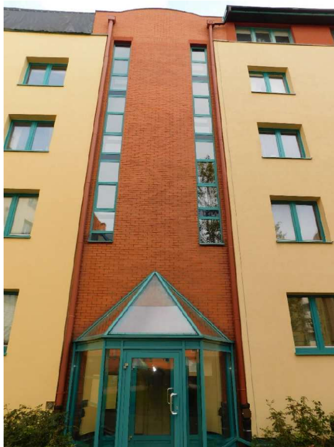
Fot nr 19. Widok ogólny elewacji
