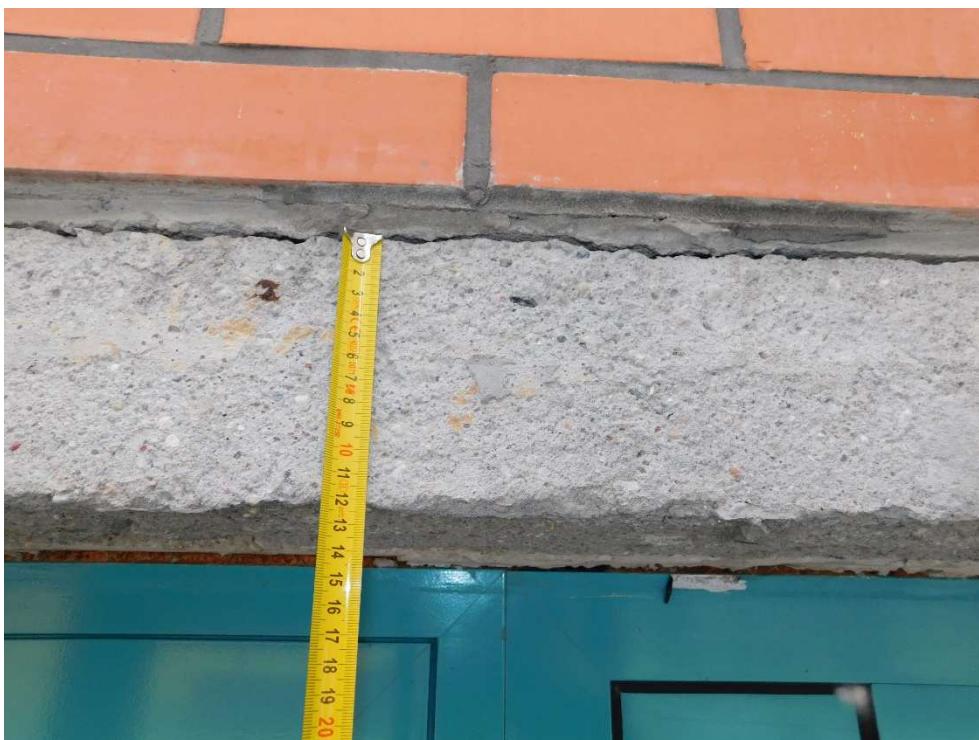
Fot nr 108. Widok nadproża wiatrołapu przy klatce schodowej nr 4
