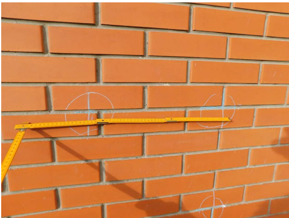
Fot nr 43. Pomiar rozstawu łączników na poziomie 3 piętra klatka 10
