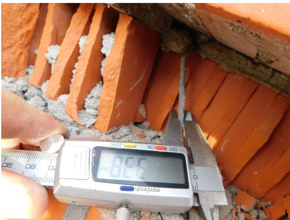
Fot nr 70. Widok pomiaru średnicy łącznika ściany klinkierowej
