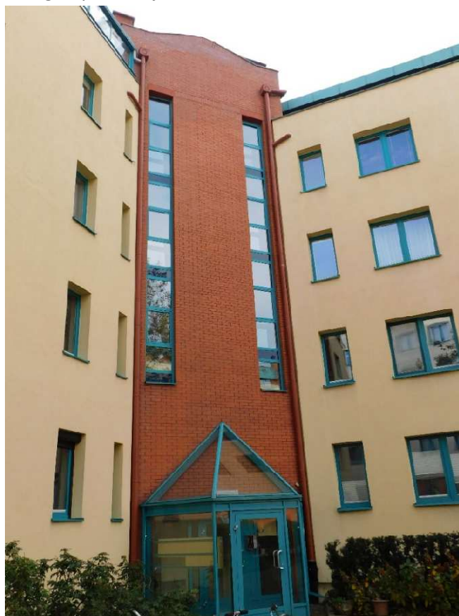
Fot nr 20. Widok ogólny elewacji
