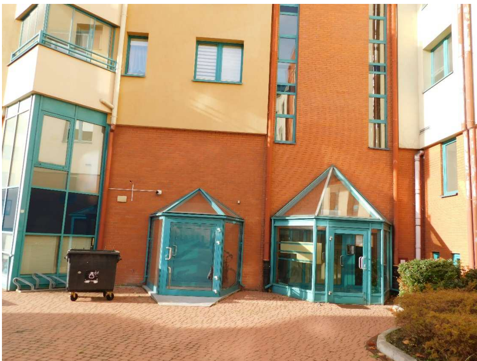
Fot nr 1. Widok ogólny elewacji
