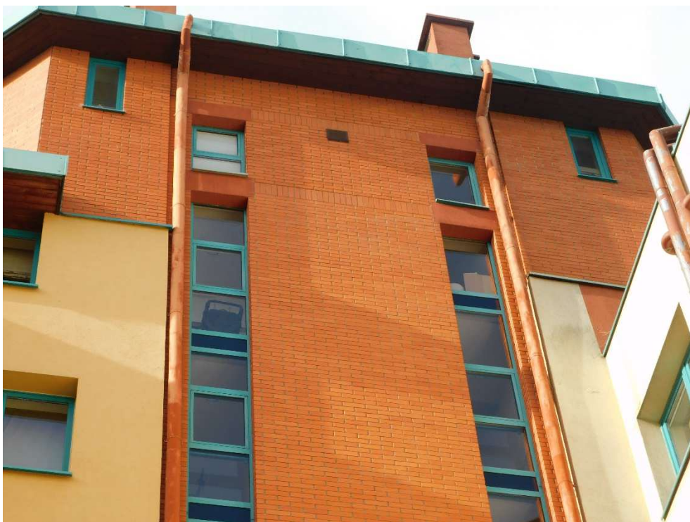
Fot nr 3. Widok ogólny elewacji
