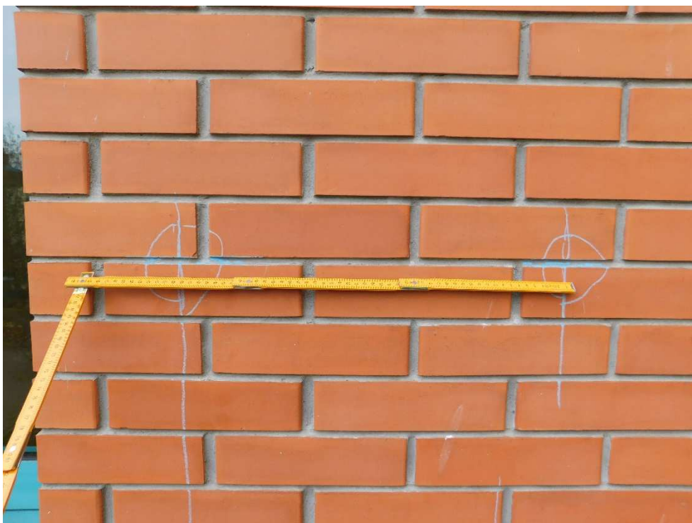
Fot nr 39. Pomiar rozstawu łączników na poziomie 2 piętra klatka 10
