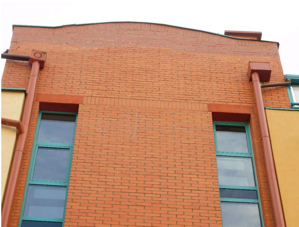
Fot nr 22. Widok ogólny elewacji
