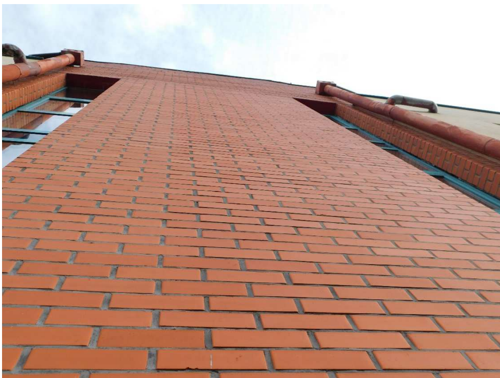
Fot nr 53. Widok elewacji nad wejściem do klatki 10 powyżej piętra 3
