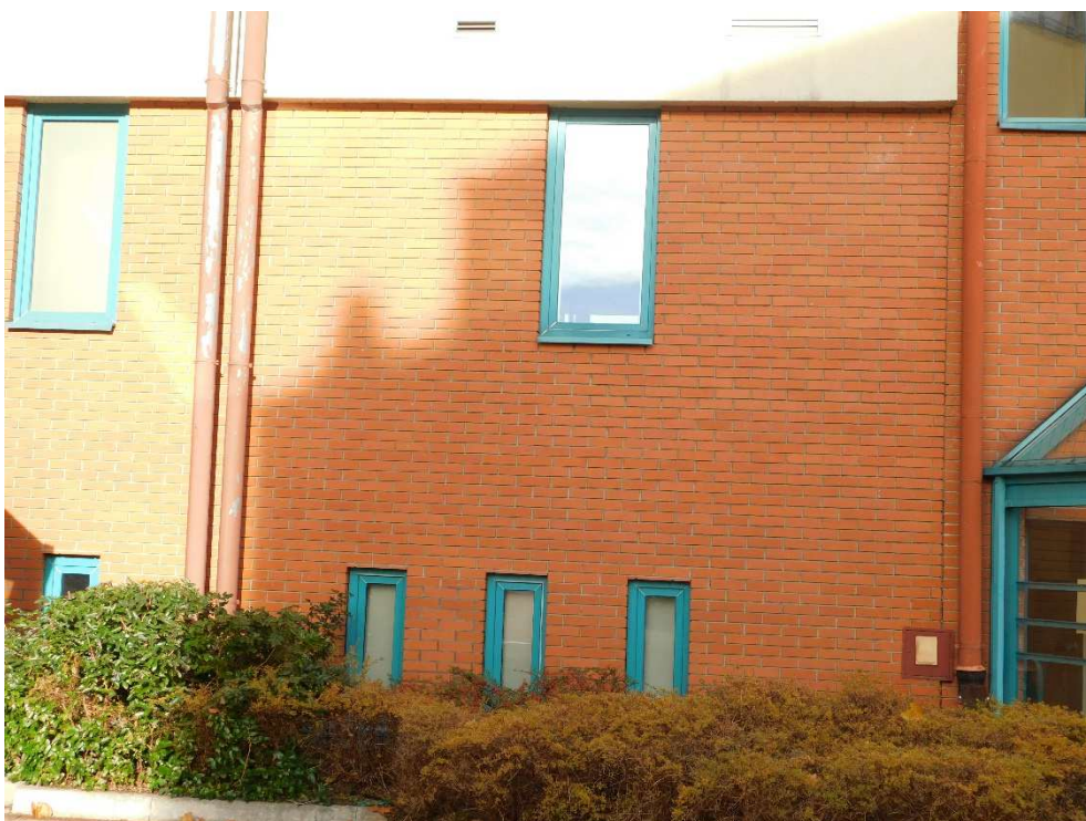
Fot nr 4. Widok ogólny elewacji
