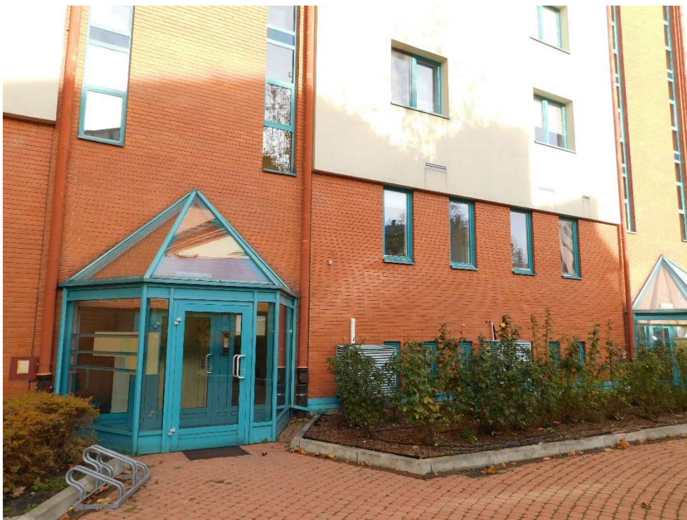
Fot nr 5. Widok ogólny elewacji
