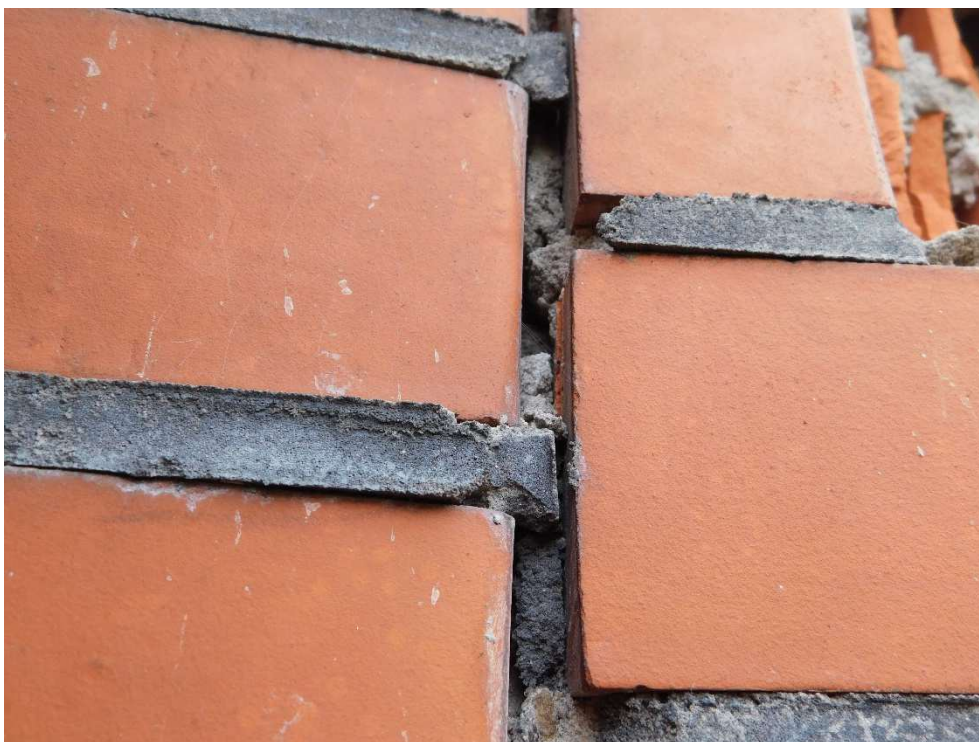
Fot nr 31. Wypełnienie dylatacji zaprawą
