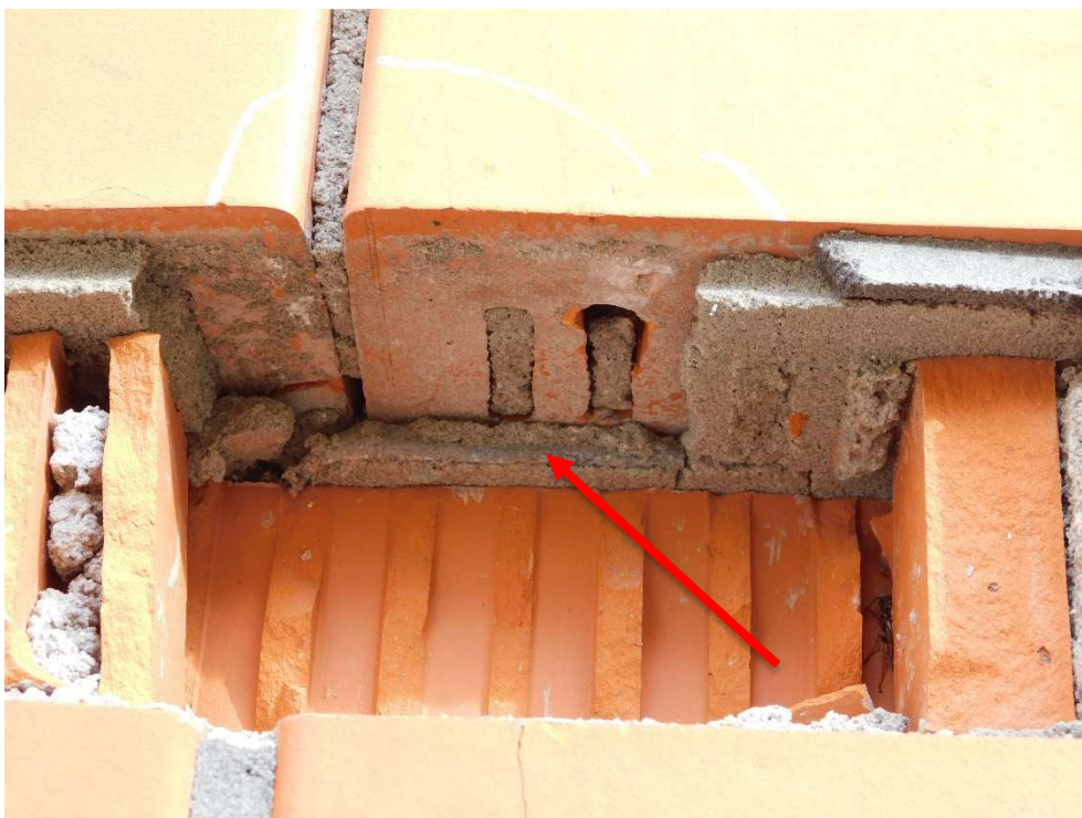
Fot nr 69. Odkrywka nr 1 – widoczny łącznik ściany klinkierowej
