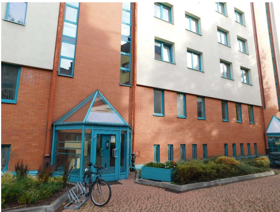
Fot nr 15. Widok ogólny elewacji
