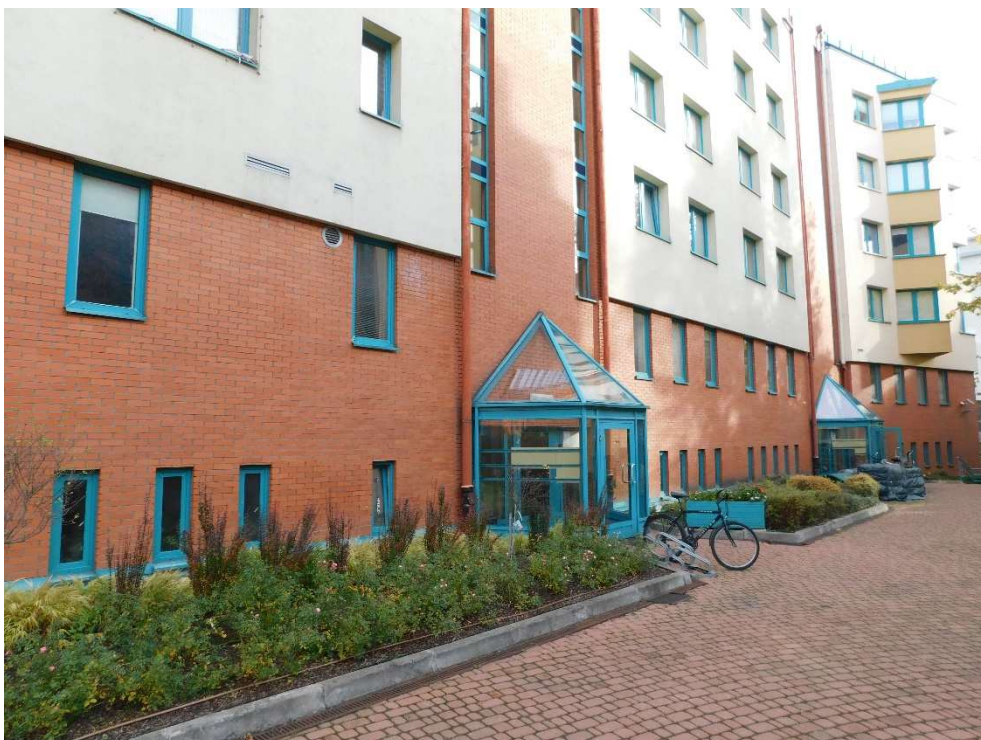
Fot nr 14 Widok ogólny elewacji
