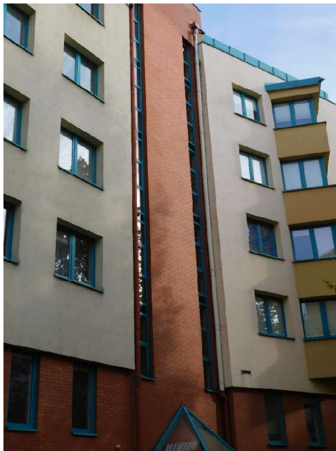
Fot nr 18. Widok ogólny elewacji
