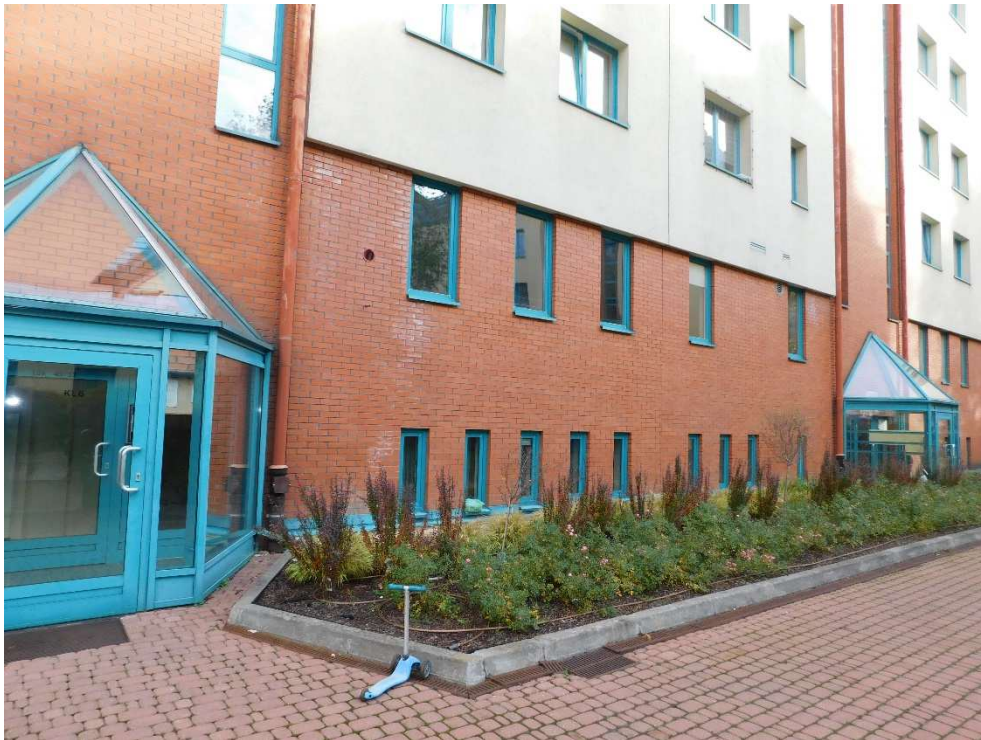
Fot nr 13. Widok ogólny elewacji
