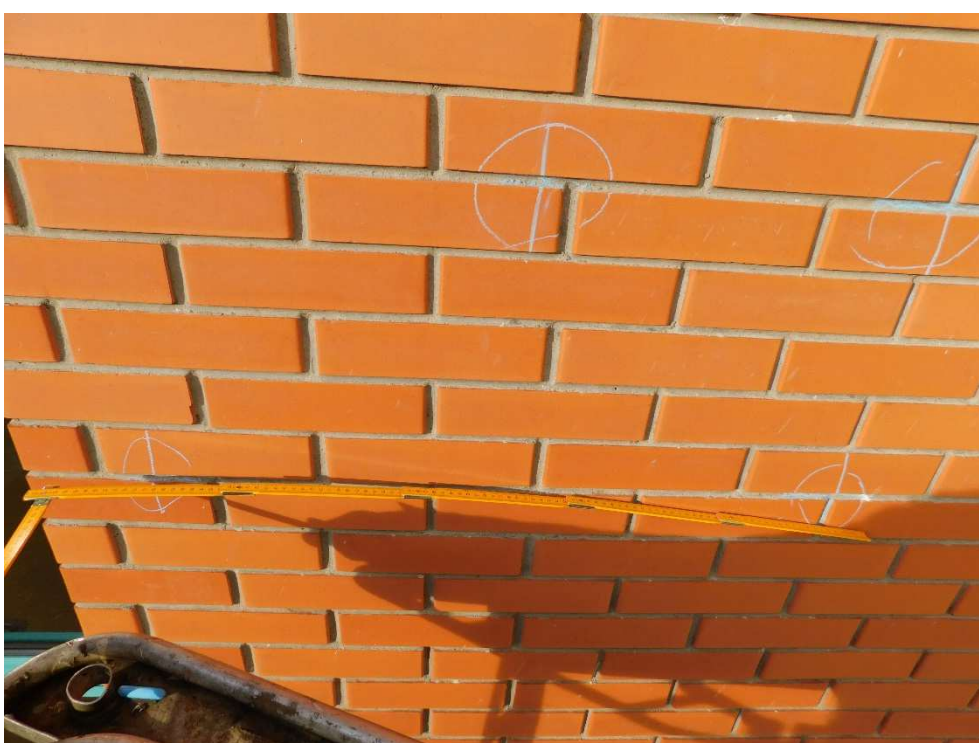
Fot nr 44. Pomiar rozstawu łączników na poziomie 3 piętra klatka 10
