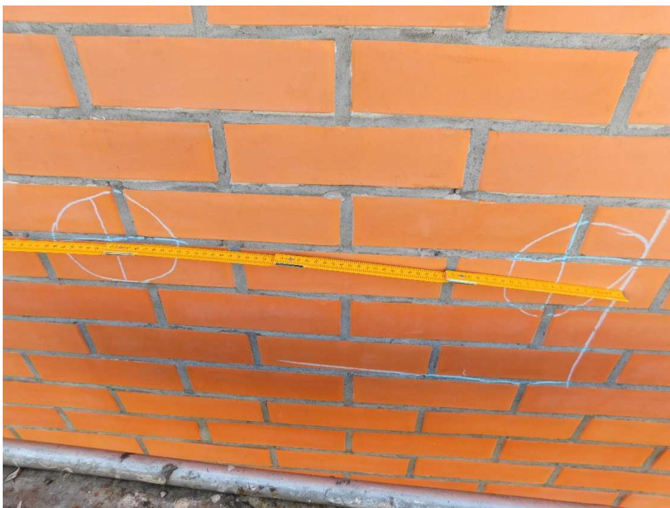
Fot nr 67. Pomiar rozstawu łączników na poziomie 3 piętra klatka 1
