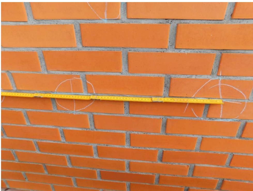
Fot nr 51. Pomiar rozstawu łączników na poziomie 3 piętra klatka 7
