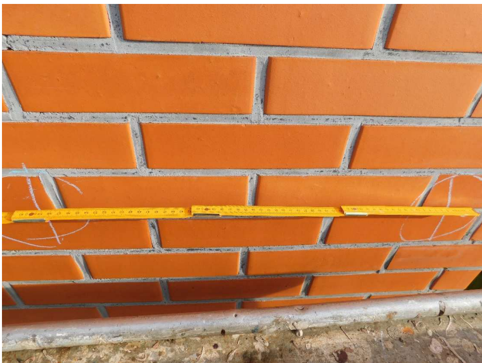
Fot nr 56. Pomiar rozstawu łączników na poziomie 3 piętra klatka 5
