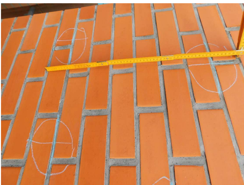
Fot nr 52. Pomiar rozstawu łączników na poziomie 3 piętra klatka 7
