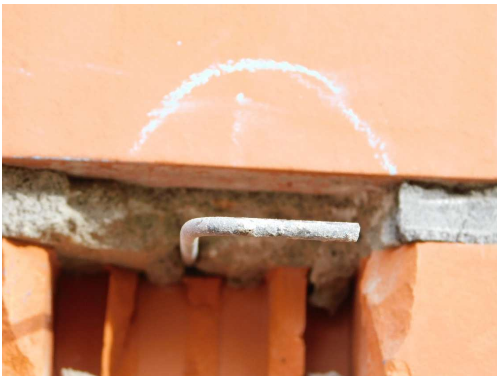
Fot nr 75. Odkrywka w miejscu detekcji łącznika stalowego
