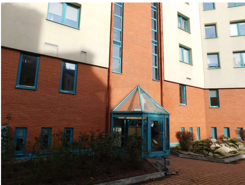
Fot nr 6. Widok ogólny elewacji
