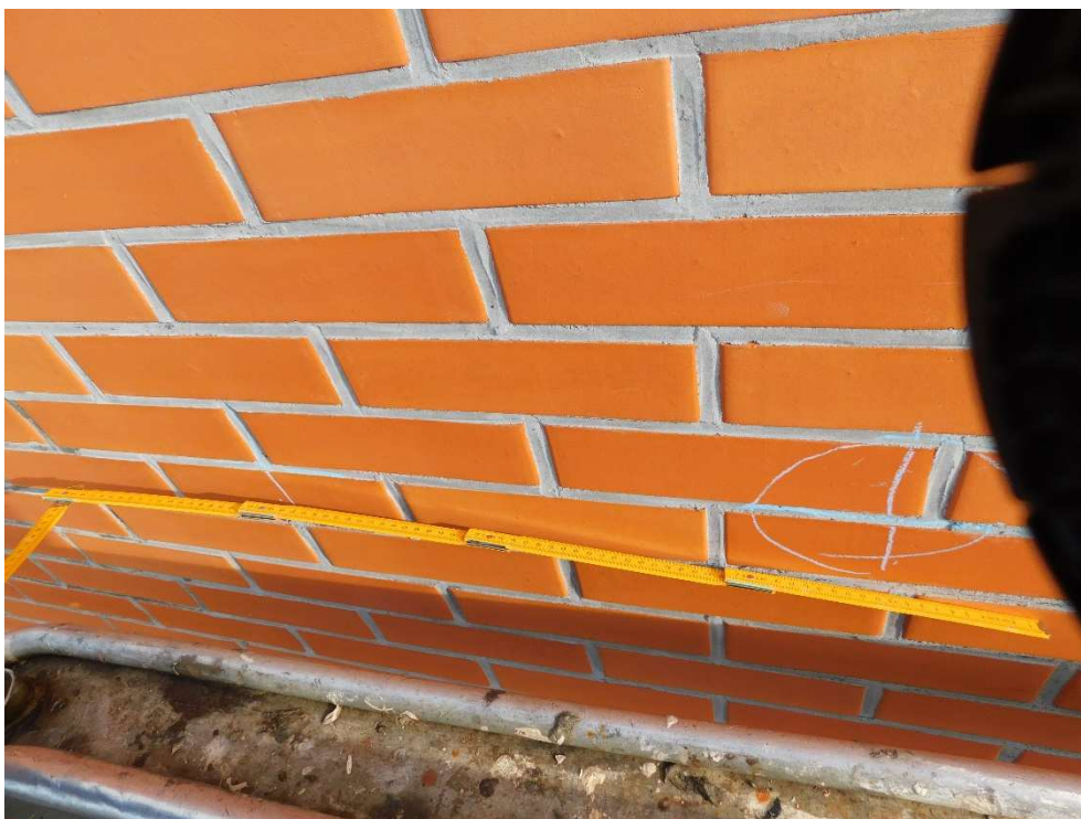
Fot nr 57. Pomiar rozstawu łączników na poziomie 3 piętra klatka 5
