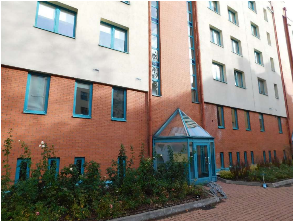
Fot nr 11. Widok ogólny elewacji
