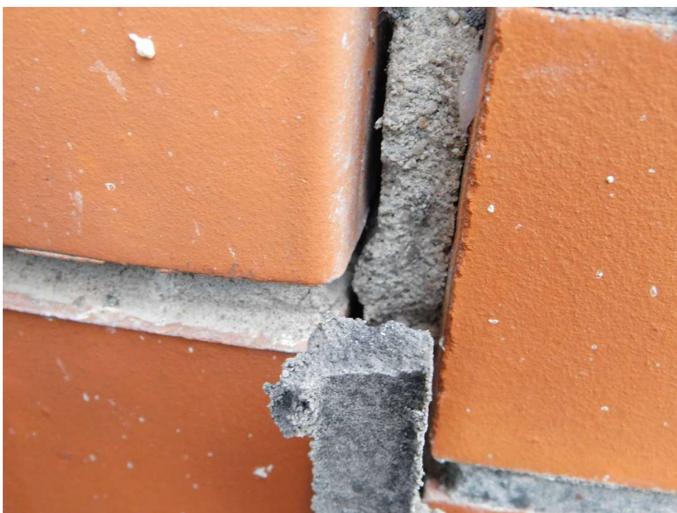
Fot nr 30. Widoczny dylatacja wypełniona zaprawą
