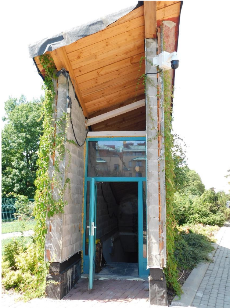
3. Widok ogólny z zewnątrz budynku 3
