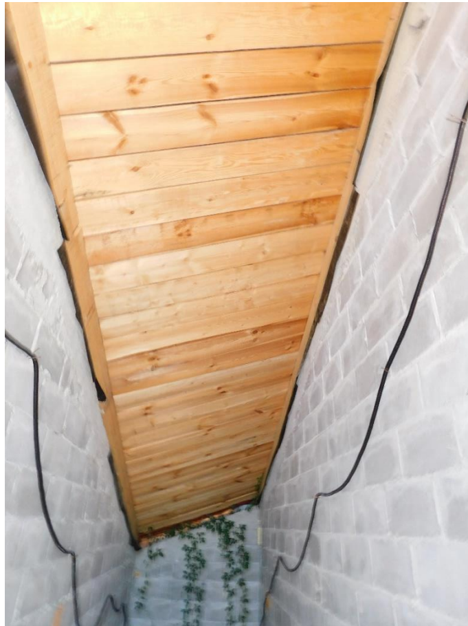
9. Widok konstrukcji dachu, elementy drewniane nie zabezpieczone przeciwpożarowo 2
