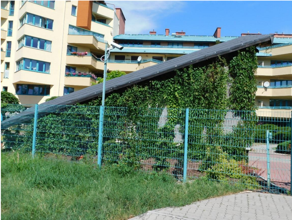
1. Widok ogólny z zewnątrz budynku 1
