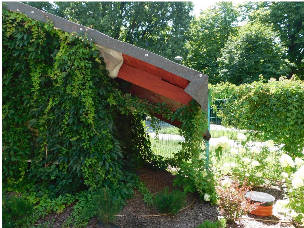
4. Widok ogólny z zewnątrz budynku 4
