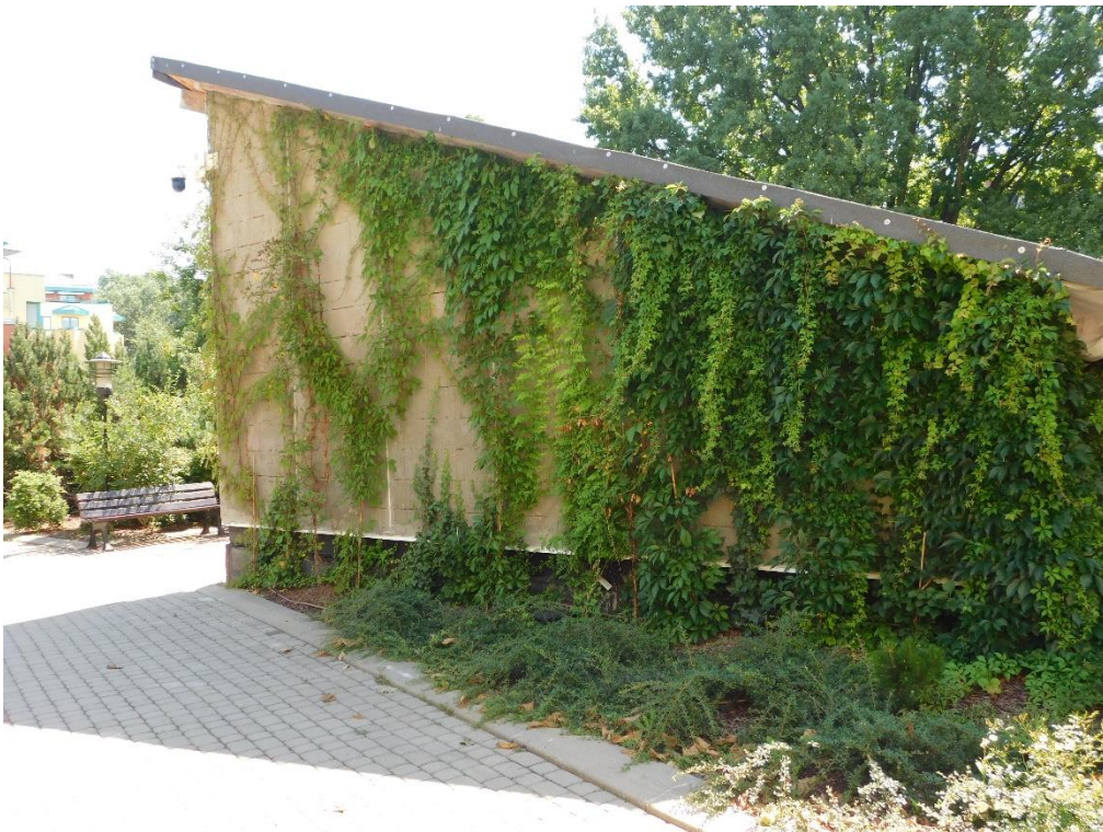
2. Widok ogólny z zewnątrz budynku 2
