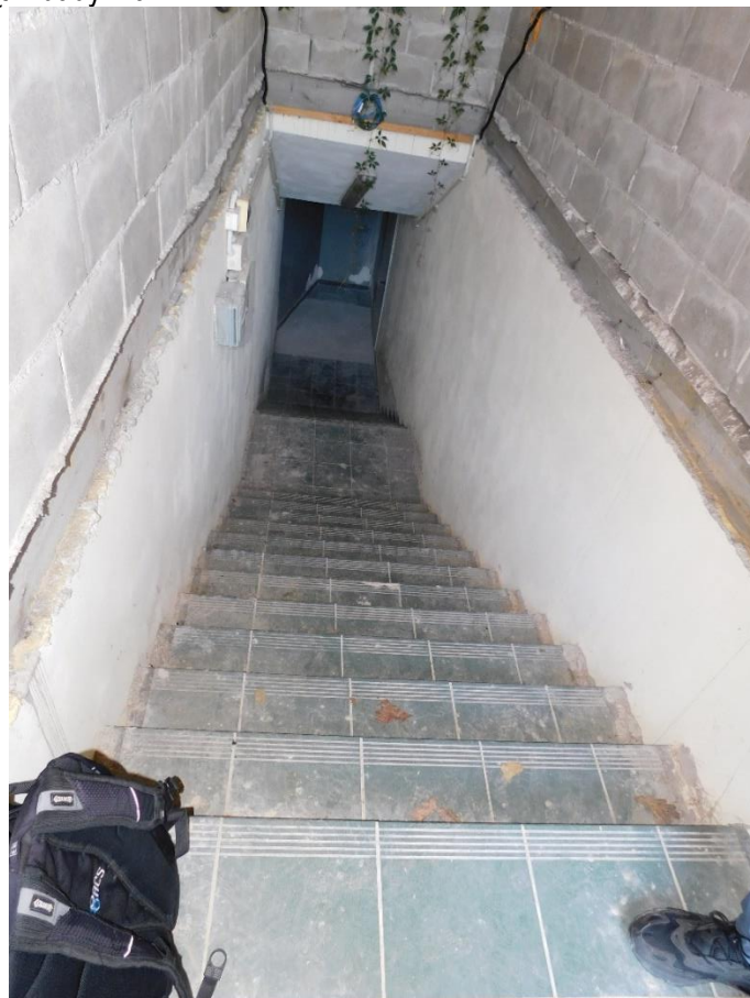
6. Widok ogólny wewnątrz budynku 2
